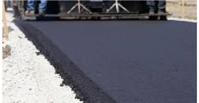
اجرای آسفالت معابر
