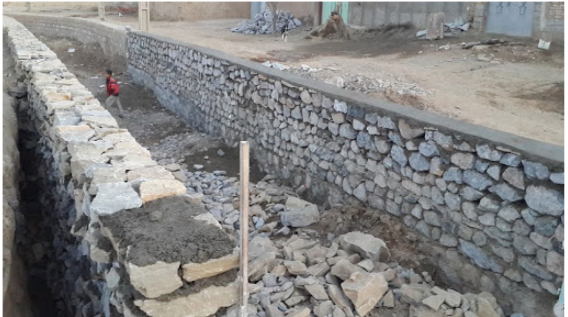
مناقصه اجرای دیوار حائل رودخانه های سطح شهر
