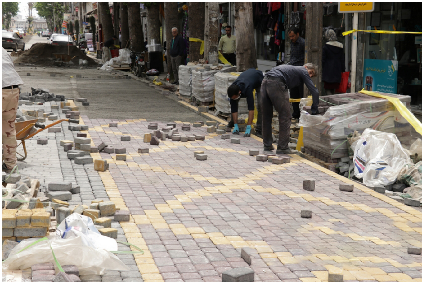
مناقصه اجرای کف سازی خیابان بسیج
