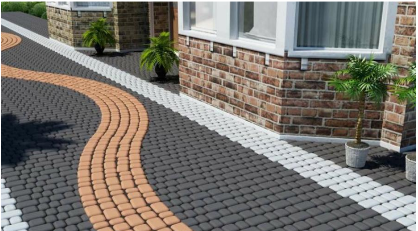
مناقصه اجرای کف سازی خیابان 22 بهمن
