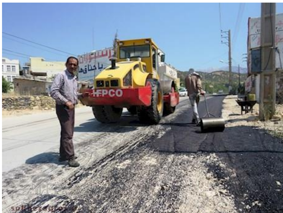
ترمیم حفاری های سطح شهر
